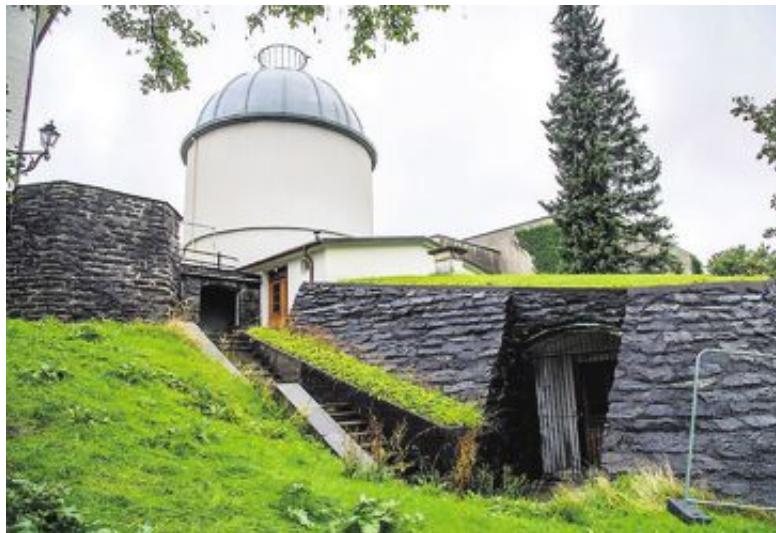
TJUKKE VEGGER: Kjernefysisk laboratorium var det første bygget som ble reist etter at UiB ble dannet. Både kuppelen og «borgen» består av flere meter tykke vegger av armert betong, for å beskytte mot stråling.
